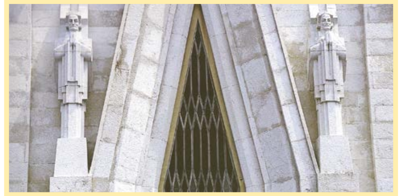
I due angeli di Venucci sulla facciata del Tempio Votivo di Cosala.
