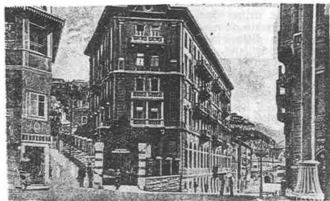
Anno 1930: a destra la discesa della via Bovio e in fondo il voltone e la scarpata della ferrovia.
