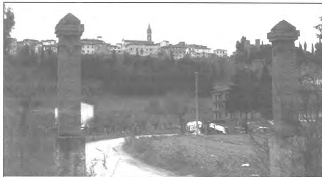
L'ingresso dell'ex campo profughi di Laterina e sullo sfondo il piccolo paese.
